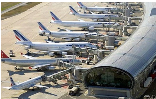
Obr. 59: Letiště Roissy GDG Zdroj: chauffeurs-services.com
